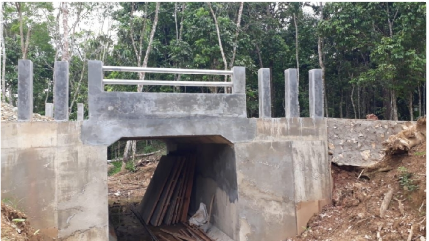
Jembatan Box Culvert Masuk Tahap Finishing
